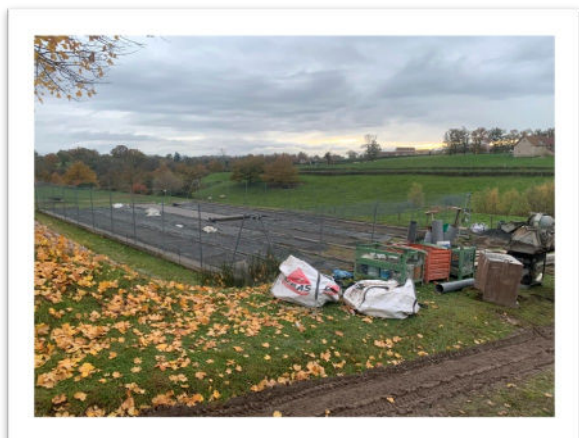
Réfection du terrain de tennis
